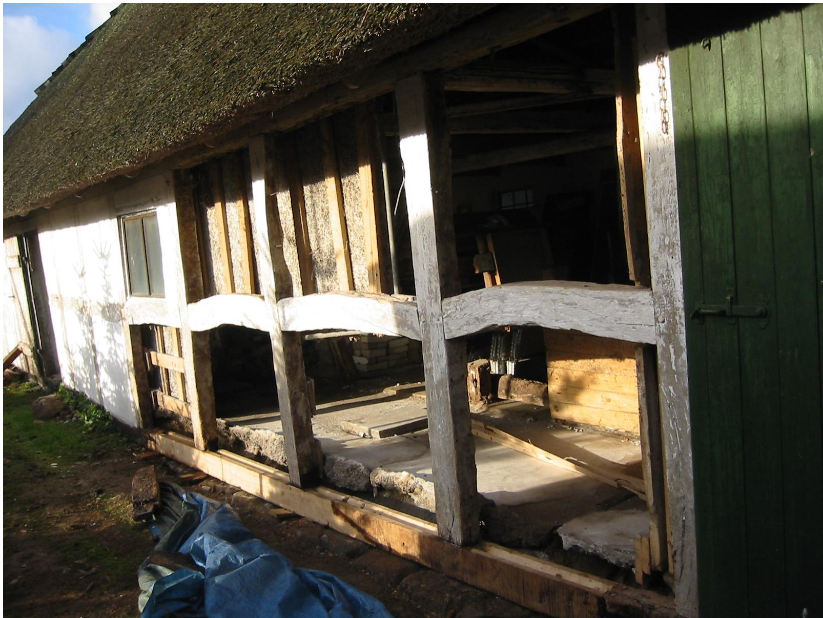
Udskiftning af et stykke fodrem, vinteren 2007
