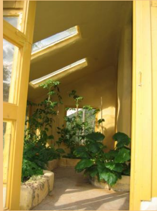
LEIREPUSS PÅ INNVENDIG VEGG
