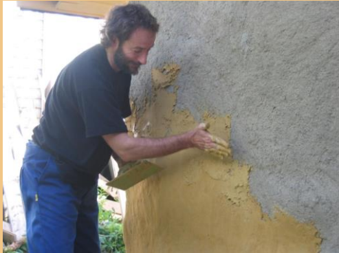
LEIREPUSS PÅ UTVENDIG VEGG
