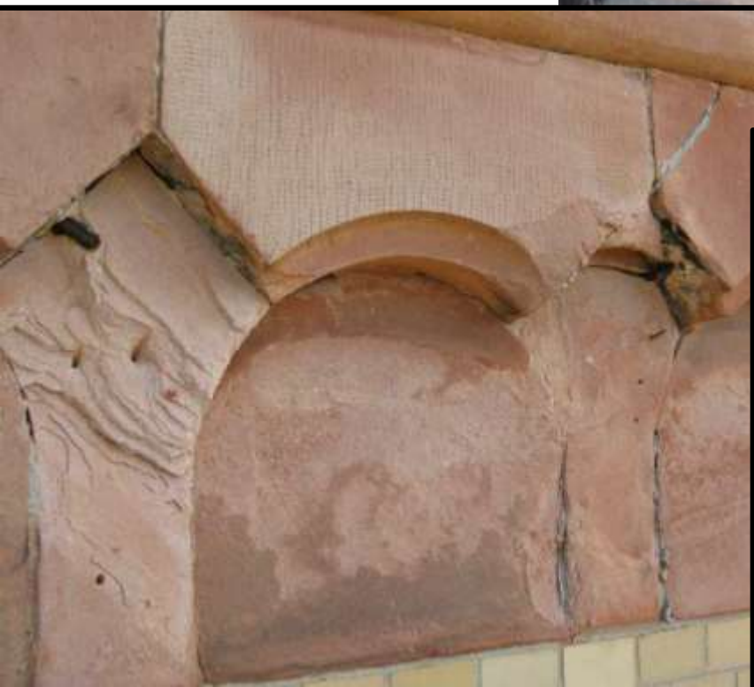
Fig. 81. Taklist av natursten med tyngdpunkten liggande innanför murlivet.
