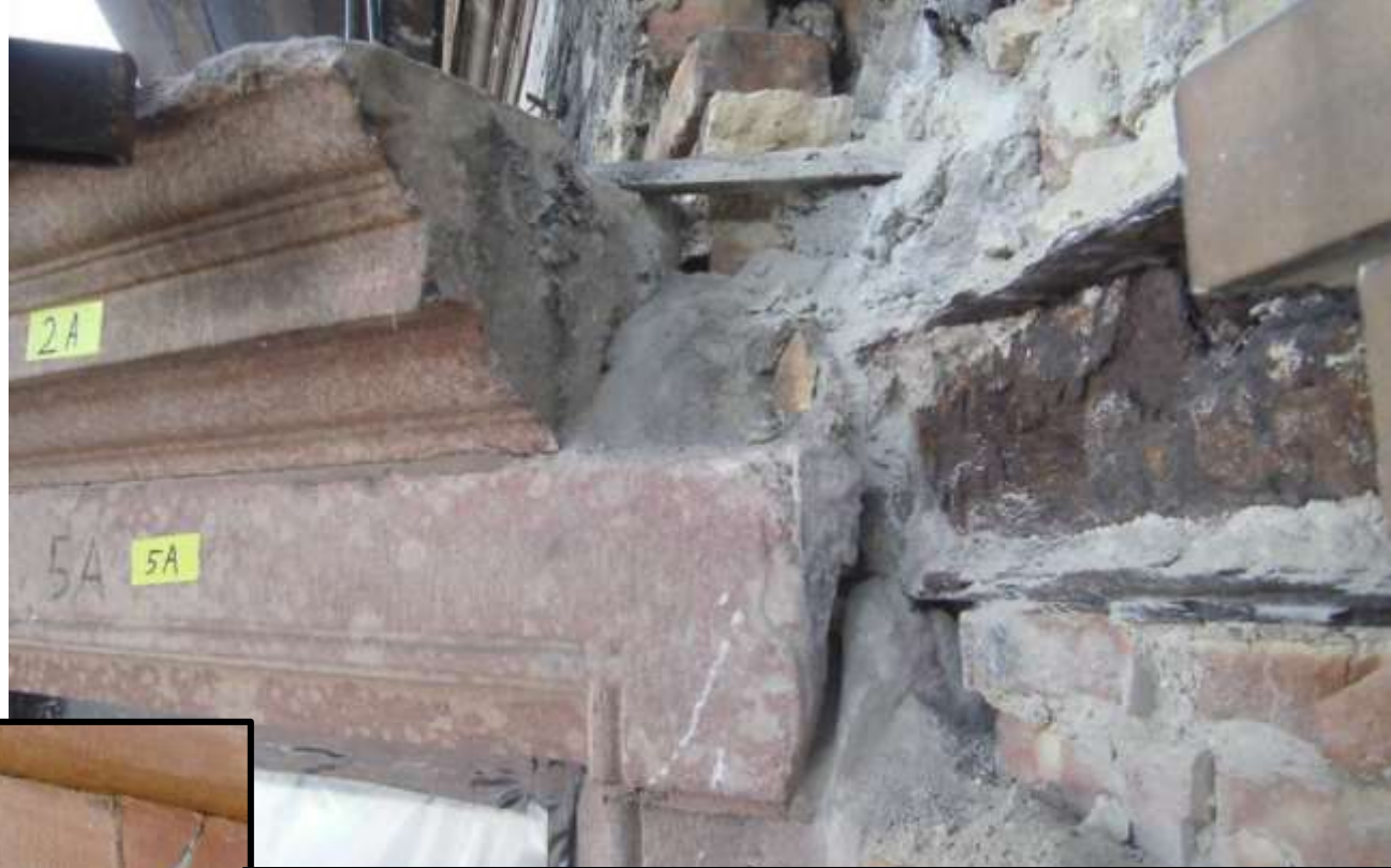
Fig. 81. Taklist av natursten med tyngdpunkten liggande innanför murlivet.
