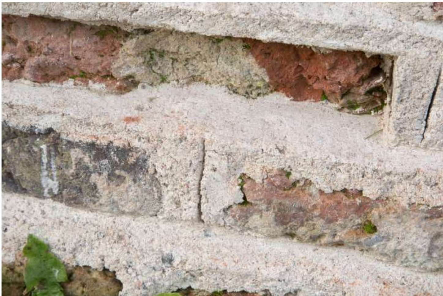
Prøvefelt nr. 3: 20% læskemørtel ( stuka släckt bruk )
