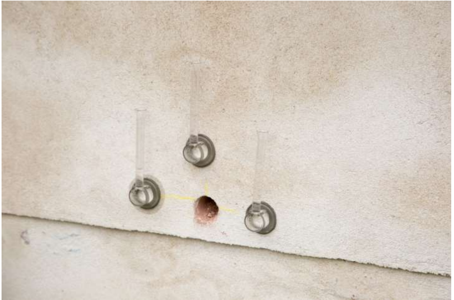
Kerneudboring – Måling af kapillarsugning – Etablering af målerør for fugtmåling
