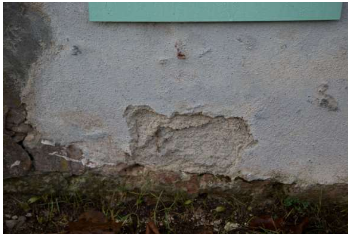
Prøvefelt nr. 6 – Hydraulisk kalk
