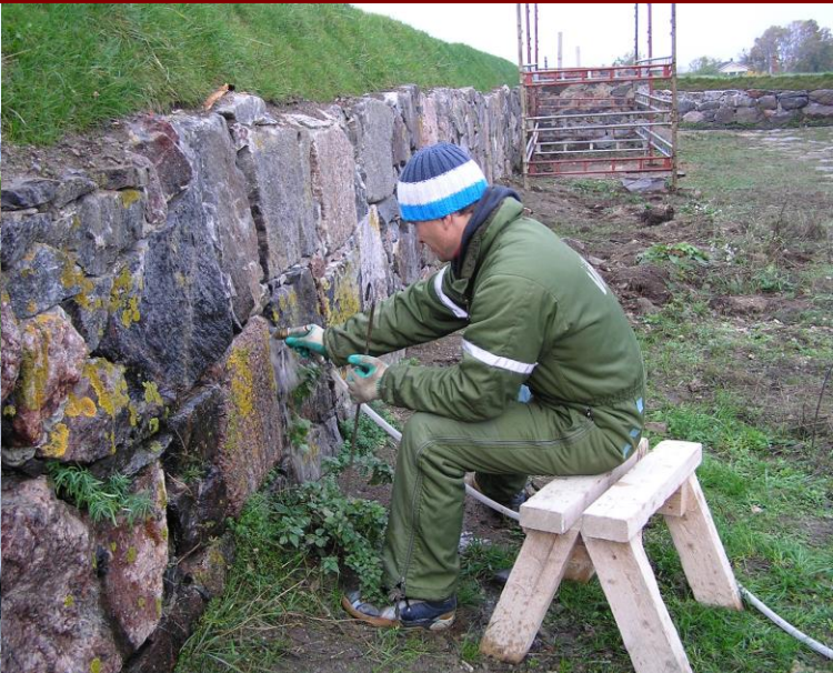
Injektering av hudrauliskt kalkbruk
