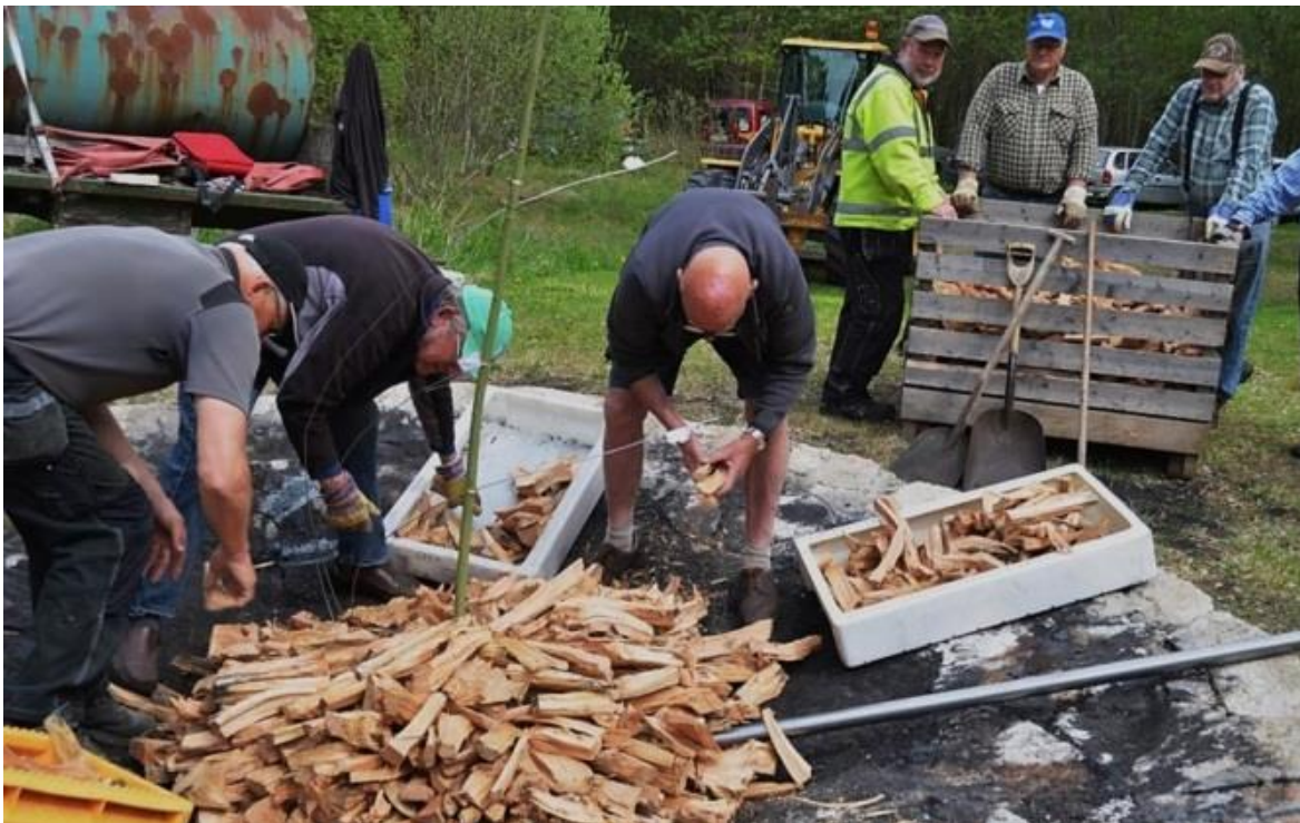
Figur 10: Montage av termoelement. Notera det skyddande järnröret.
