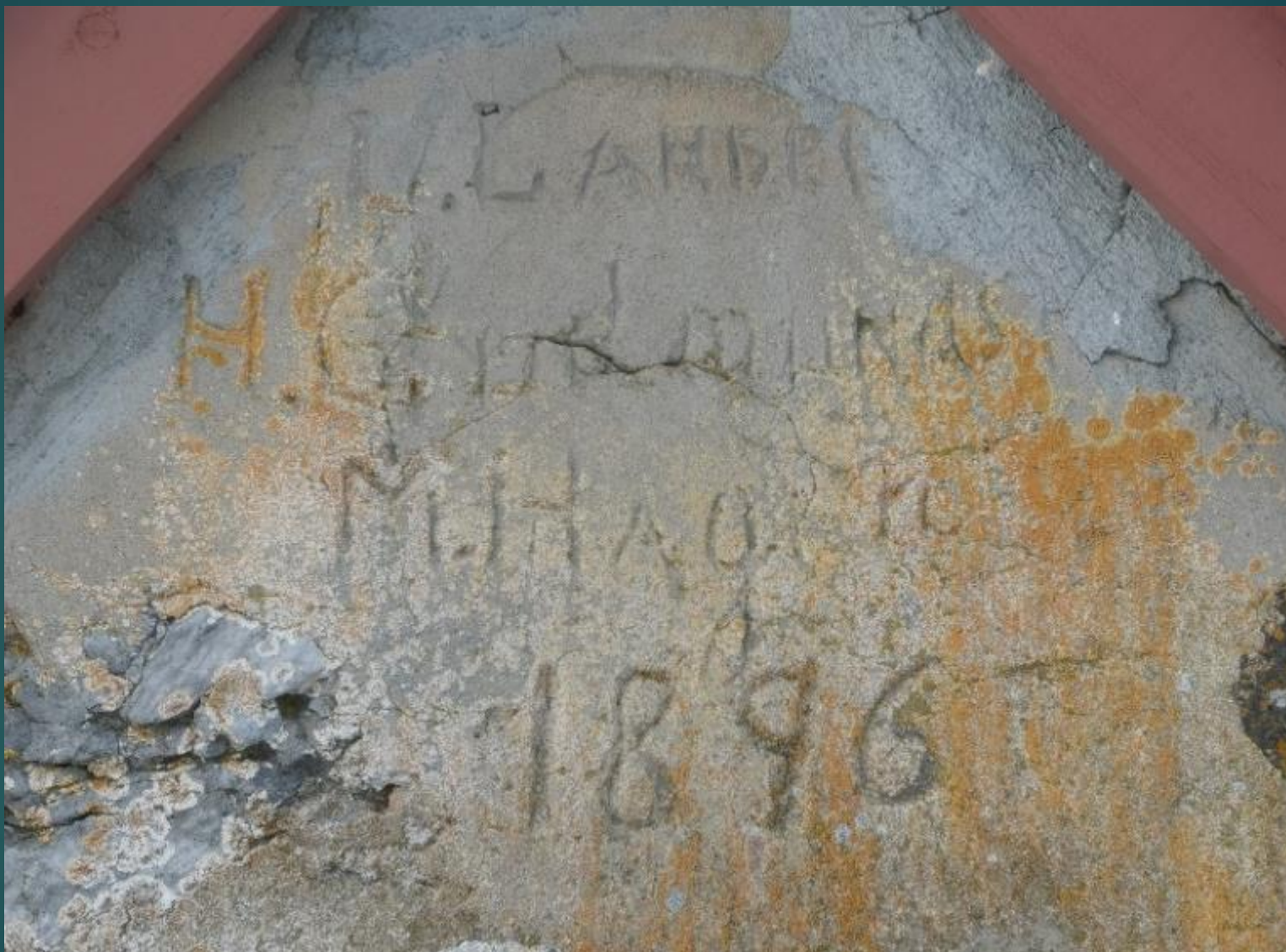
Håndverkersignaturer i sementen i korets østgavl fra murarbeider i 1896. Det var ganske sikkert da restene av puss ble hugget ned og alle kalkfuger ble spekket med sement.
